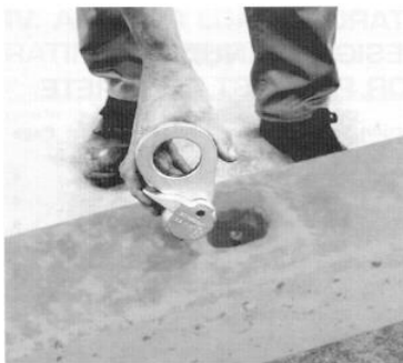
Figur 2 Forbindelsen mellem Starcon løfteøjet og Starcon Anker er hurtig og nem.
